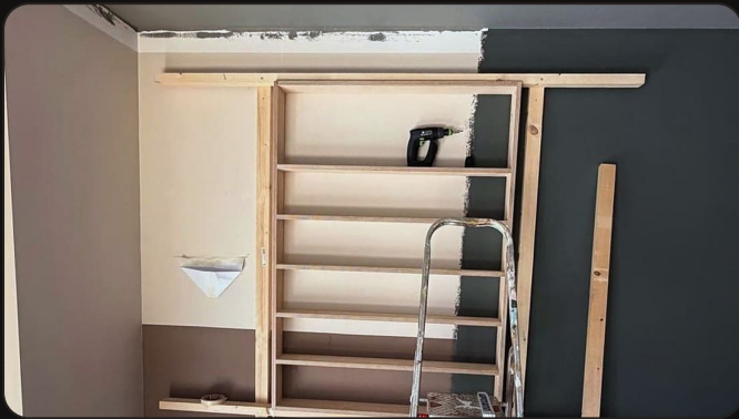
JULI 2026 • REGALNISCHEN IM ROHBAU
